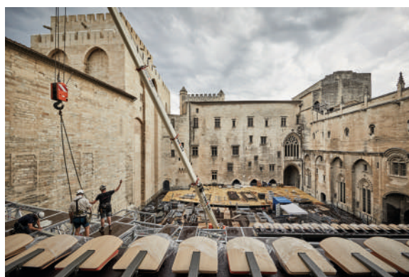
Construction des nouveaux gradins de la Cour d'honneur, 2021 © Christophe Raynaud de Lage
