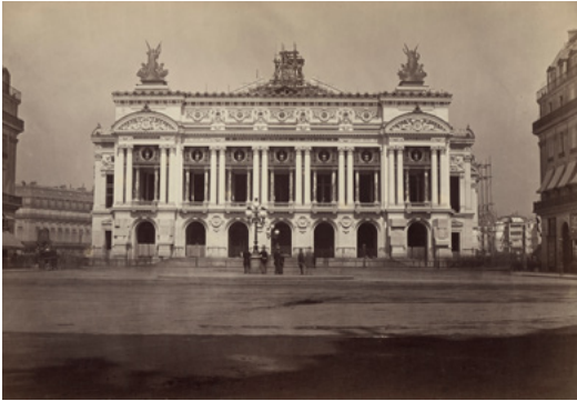
Louis-Émile Durandelle, Chantier de construction de l'Opéra Garnier. Façade principale 1867 - Photographie BnF, Bibliothèque-musée de l'Opéra
