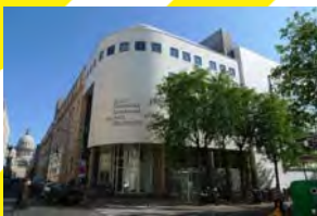
Façade extérieure, angle des rues d'Ulm et Erasme Photographe Sudre Laurence Copyright EnsAD
