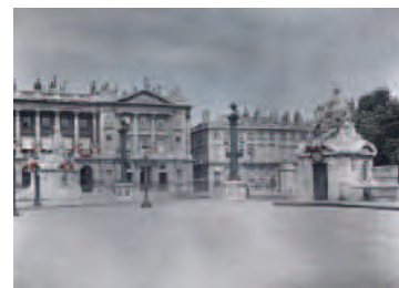
Paul Castelnau, hôtel particulier, 2 rue Saint Florentin, place de la Concorde Tirage d'après autochrome © Ministère de la culture, Médiathèque de l'architecture et du patrimoine, RMN
